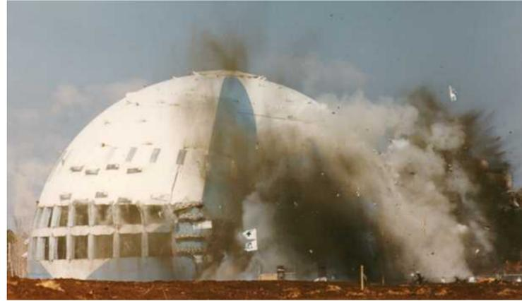
■RC集合住宅発破倒壊実験工事 (1988年10月 長崎県)
