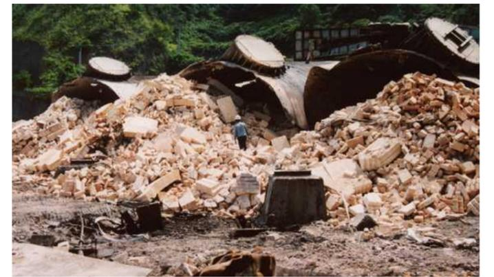
■八敷代川橋りょう撤去工事 (1期工事) に伴うトラス発破切断工事 (2003年1月 山形県)
